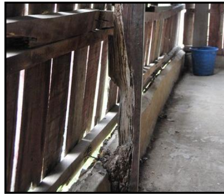
Le toit du bâtiment est troué, et les piliers sont rongés par les termites.
