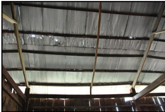
Le toit du bâtiment est troué, et les piliers sont rongés par les termites.
